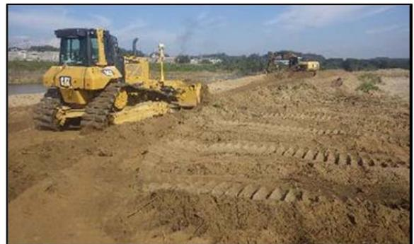
図-7 MCブルドーザーによる掘削状況
