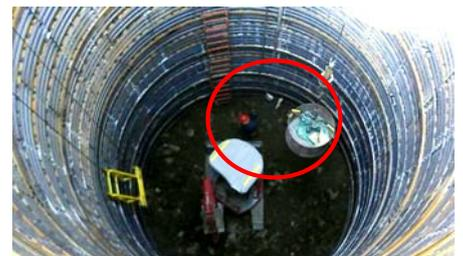
吊り上げるバケットと作業員の距離が近い
