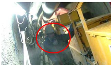
掘削中のトンネル坑内で防塵マスクを外している
