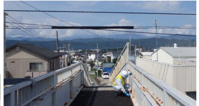
fig.7: 横断歩道橋上の架線の建築限界確認
