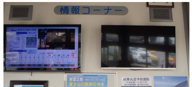
fig.8: 道の駅情報板の不点灯確認
