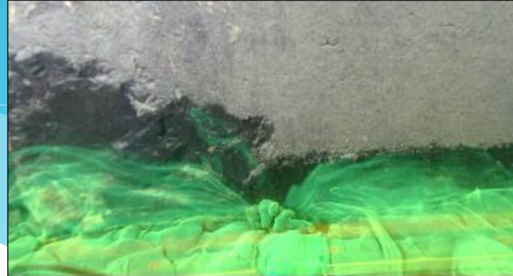
漏水経路確認のためトレーサー放出
