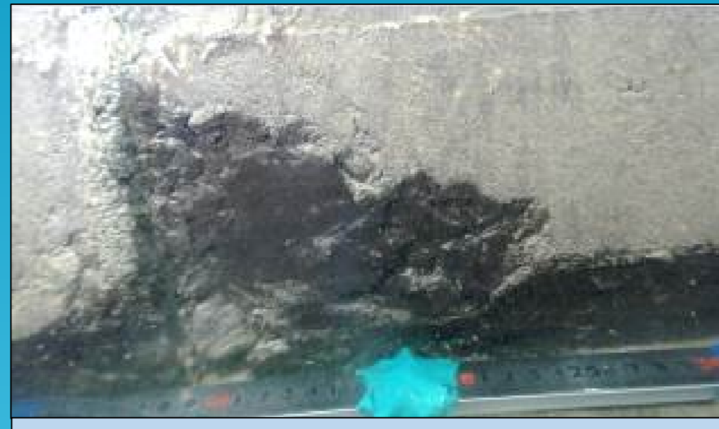
水中ROVによる、堤体を潜水調査
