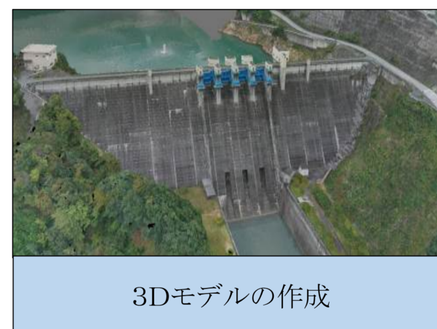
UAVによる劣化含む堤体撮影
