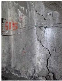
吹付けコンクリートのせん断クラック、押し出し
