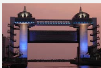
写真 大型展望水門「びゅうお」（沼津市）
