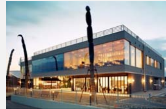
写真 旅客船ターミナル併設商業施設 ベイシスカ（津市）
