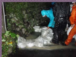
漏水の発生（H16年9月洪水）
