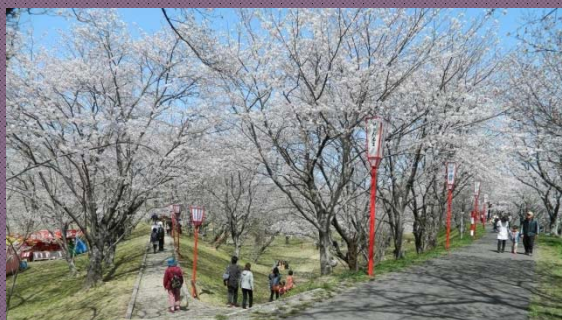
改修前の宮川堤防と桜（4月）の状況
