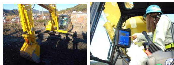
図-7_写真（左：ICT建機による掘削作業、右：操縦する女性オペレーター）
