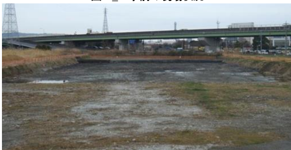
図-3_工事後の現場状況
