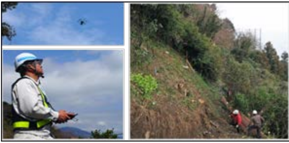
(写真3) UAVによる3次元起工測量
