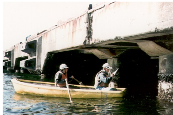
図-2 栈橋下への進入状況
