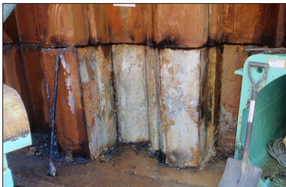
写真 - 4 鋼矢板切断後の地盤状況
