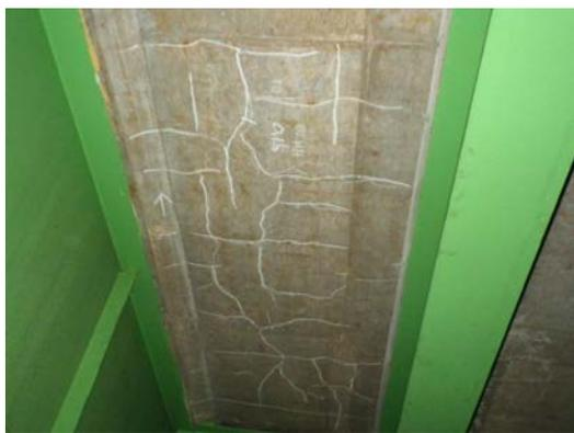
写真-2 RC床版の疲労によるひびわれ
