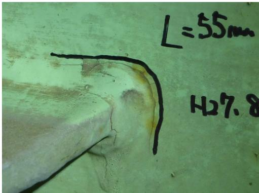
写真-8 主桁補剛材に発生した疲労亀裂
