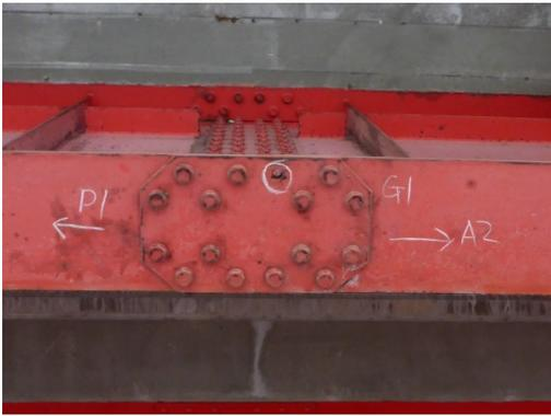
写真-10 HTB(F11T)の遅れ破壊による脱落
