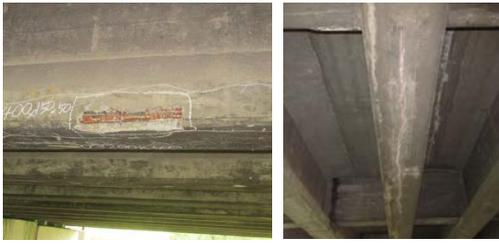
写真-7 PCT 桁橋のPC 鋼材に沿った鉄筋露出およびひびわれ
