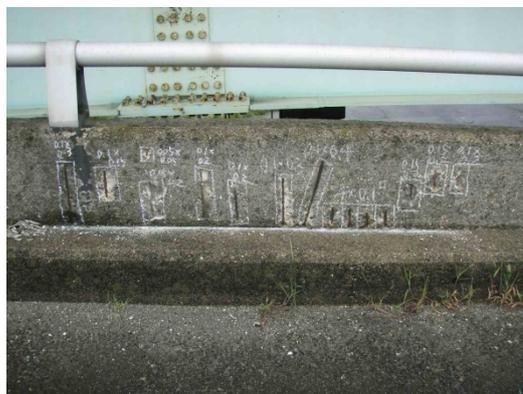
写真-6 中性化によるコンクリート部材の剥離・鉄筋露出
