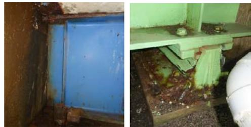
写真-9 腐食 (左) 主桁, (右) 支承
