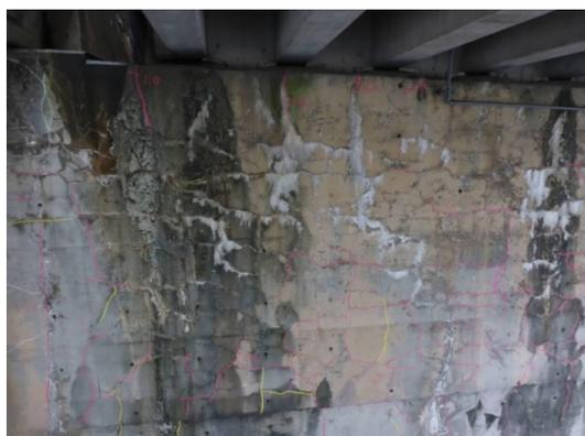
写真-5 ASRによる橋脚梁のひびわれ
