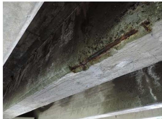
写真-3 外的塩分によるコンクリート部材の塩害状況
