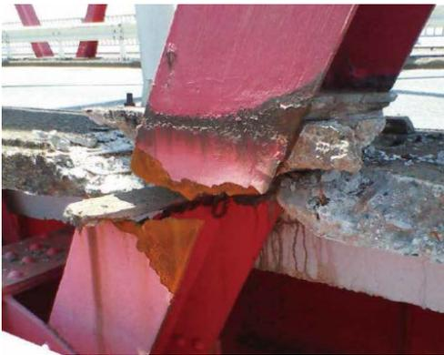
写真-11 鋼部材の破断
