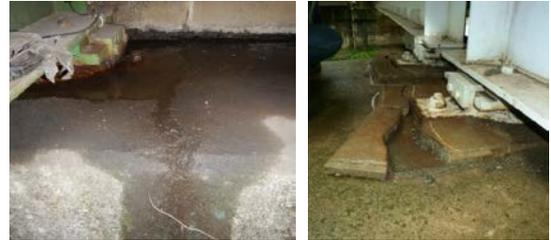
写真-13 沓座面の滞水および沓座モルタルの欠損
