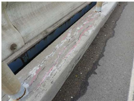
写真-4 地覆部の凍害(スケーリング)
