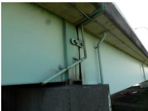
写真-12 鋼橋ウェブの変形
