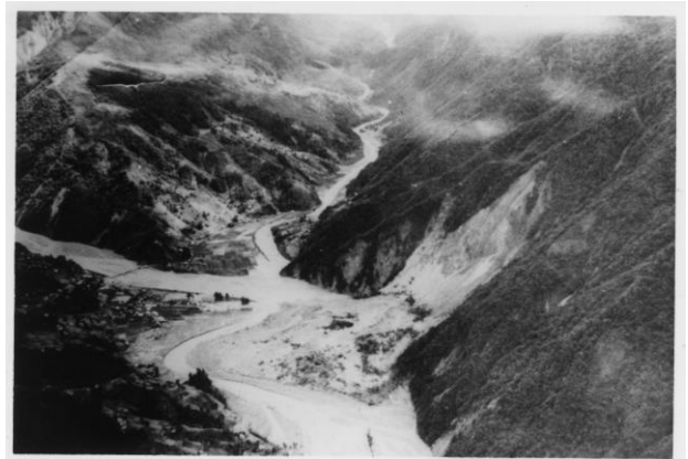
図-2 36災害で崩落した大西山（下伊那郡大鹿村）
