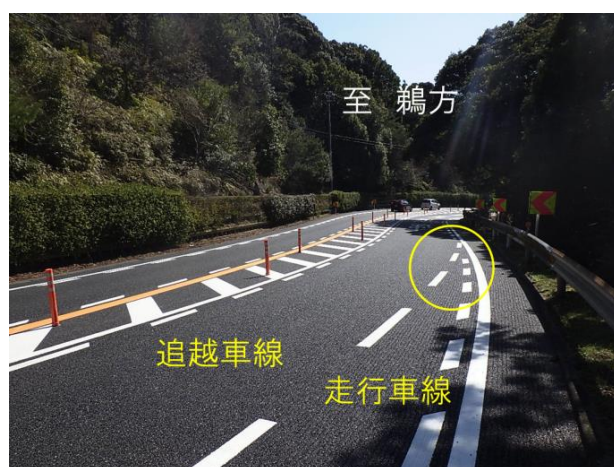
図-10 追越車線・走行車線の分岐箇所（工事後）
