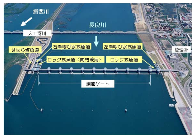
図-1 長良川河口堰に設置されている魚道
