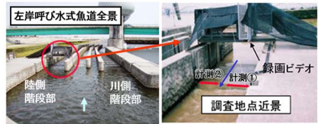
図-2 左岸呼び水式魚道陸側魚梯部での稚アユ遡上数測定概況
