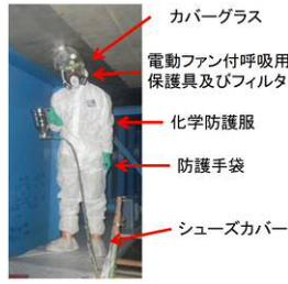
写真-2 養生設備, 作業員の安全確保の状況
