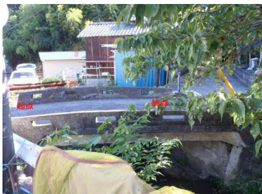
図-9 無名橋566（（市）興津本町11号線）全景写真
