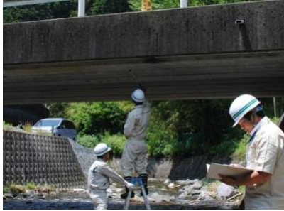
図-4 静岡市職員点検実施風景
