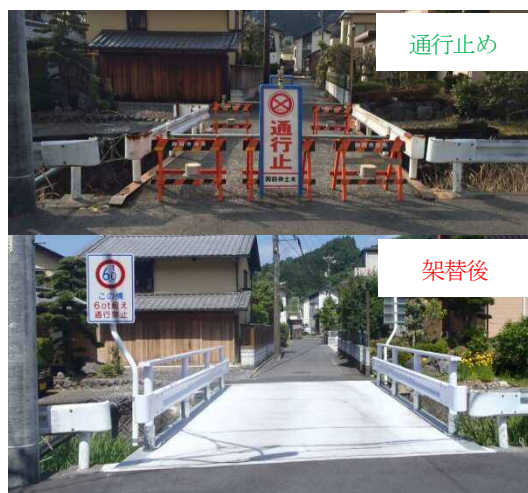
図-13 Ⅳ判定橋梁対策前後（通行止め後上部工架替）
