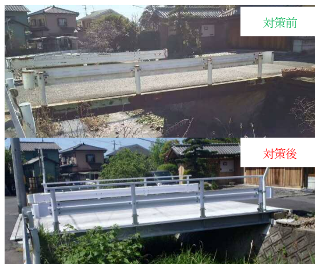
図-15 Ⅳ判定橋梁対策前後（全景写真）
