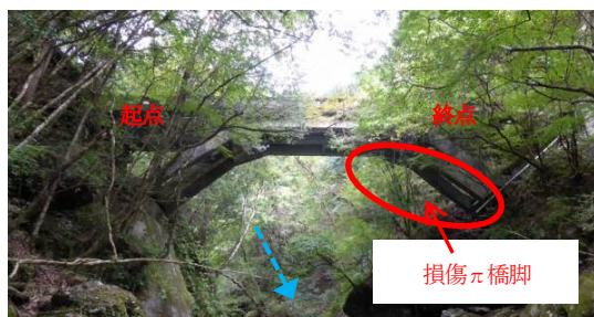
図-7 大畑橋（主）南アルプス公園線）全景写真
