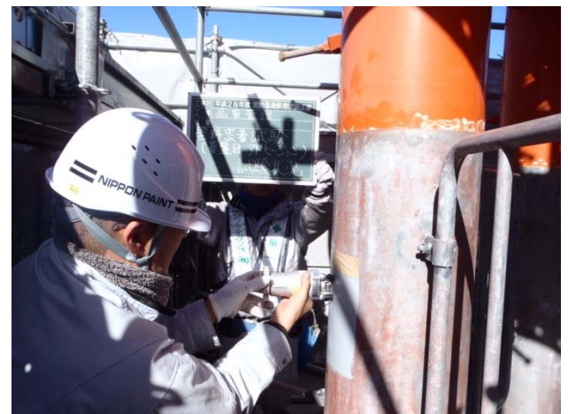
写真-4 塗装密着付着試験状況写真
