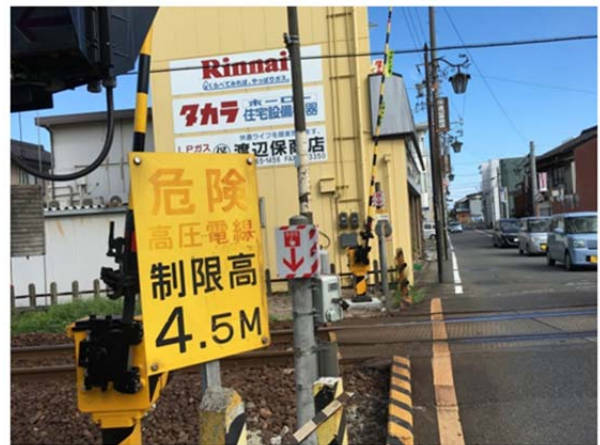
写-6 踏切高制限、路面段差と架空線
