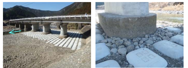
写真-3 根固めブロックの設置状況
