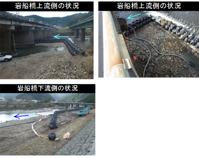
写真-2 左岸締め切内の水替え状況
