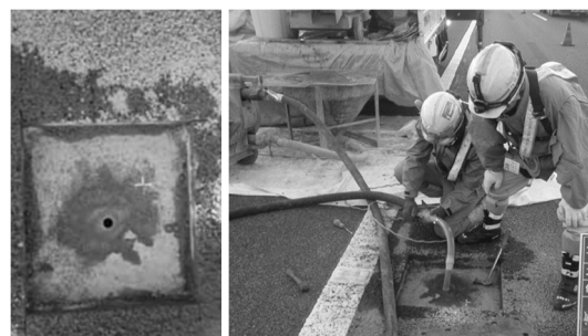
図一6 開孔部、グラウトの注入の様子
