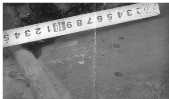
図一 8 健全な鋼床版の様子
