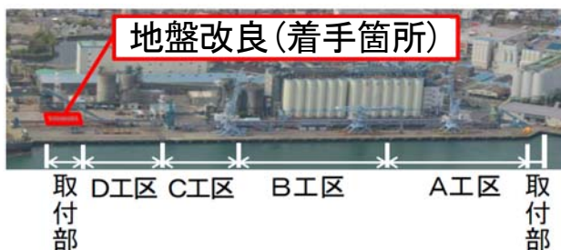
写真-4 平成27年度の施工箇所.
