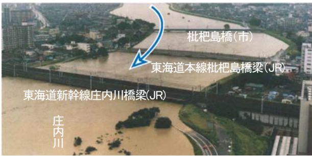
図ー2 東海豪雨（平成12年9月）
