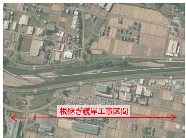
写真-1 平成18年の出水後
