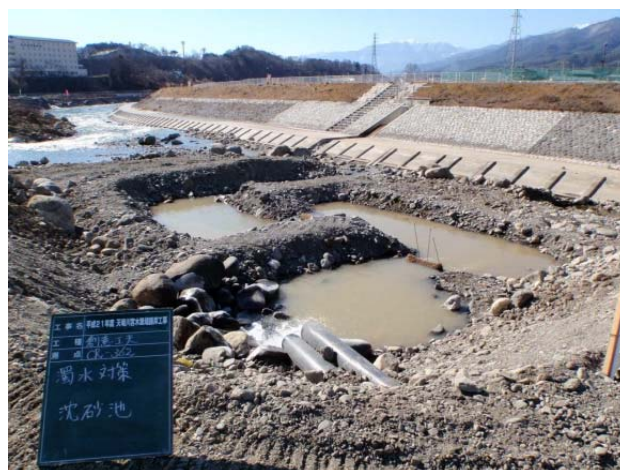
写真-5 沈殿池による濁水対策の一例
