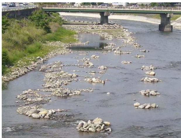
写真-4 大石設置の極端な失敗例
