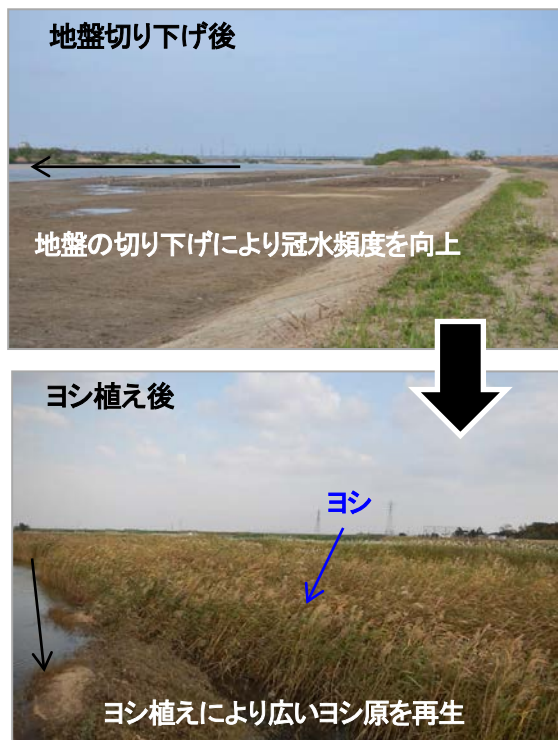
図13 ヨシ原の施工状況
