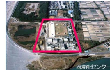
浜松市西遠浄化センター
