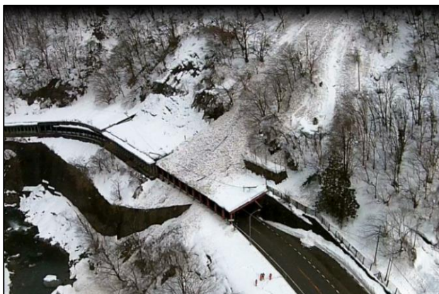
図4 神岡町東漆山での雪崩状況
