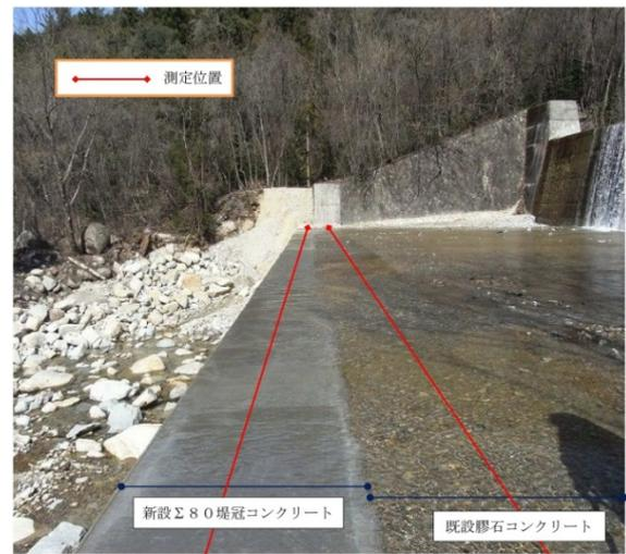
基準点は流失を防ぐため、下流へ腹付けした堤冠コンクリート部分には袖部を打設していないため流水の影響を受けない箇所があり、水通し下幅から 2.0m 外側に左岸・右岸それぞれ 1 対の測量鉾マーカーを設置し高さの基準点とした。
