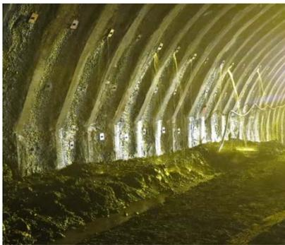
写真-3. トンネル施工時の湧水状況
