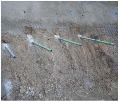
写真-2. 地表面の水抜き対策
