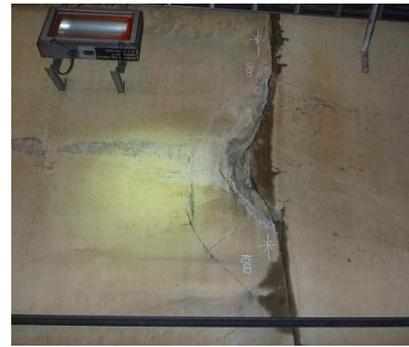
写真-1. 漏水の影響によるコンクリートの損傷の事例
