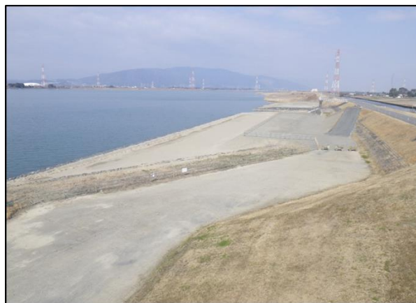
写真-4 堤防強化（高水敷整備）
