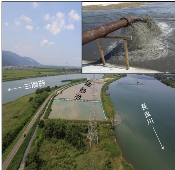
図-2 しゅんせつ工事の作業イメージ
