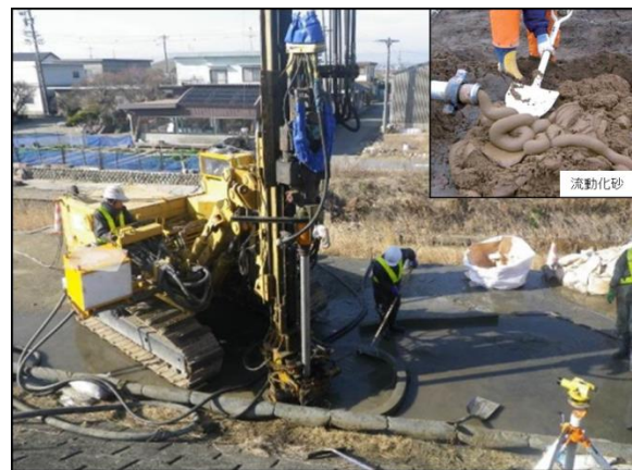
写真-3 堤防の耐震対策（砂杭）への活用
