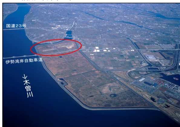
写真-5 他の公共事業 （木曽岬干拓地整備事業）での活用
