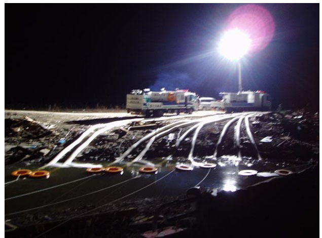
写真－2 夜間排水状況
