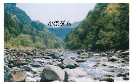
写-1 ダム下流現況写真
