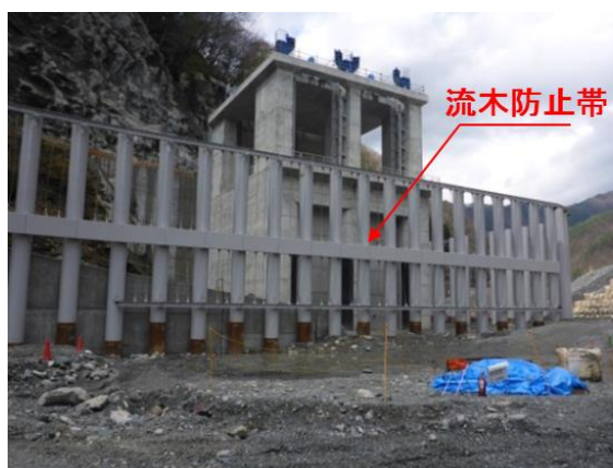
写-3 流木ハネ正面写真
