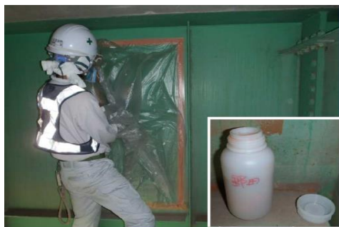
図-1 野田高架橋の塗替前 事前塗膜調査状況
