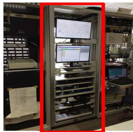
図-5 災害対策室のヘリサットシステム設備
