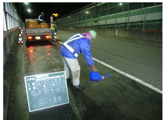
図-6 凍結路面への塩水散布状況
