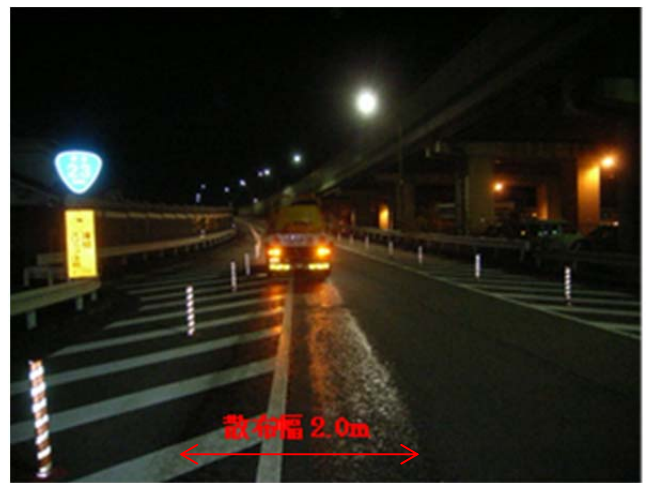
図-12 事前散布 1 回目 (H28.1.24 21:45) 国道23号築地口オンランプ
