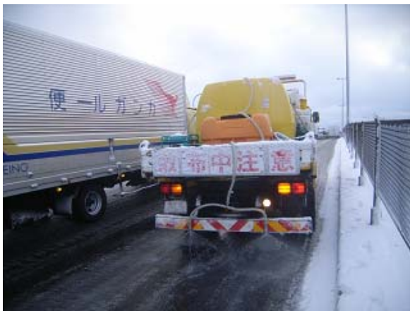
図-3 塩水散布の状況
