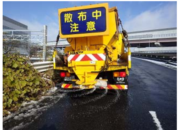
図-1 固形剤散布の状況
