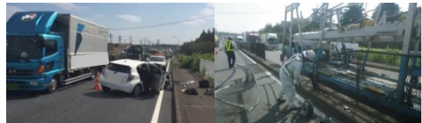
写真-7 交通障害発生時の対応状況
