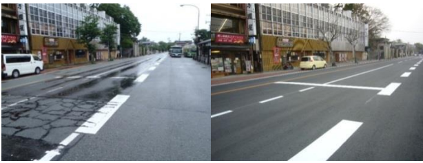
写真-2 舗装・区画線補修（左：補修前 右：補修後）
