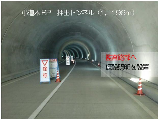
写真-2 照明施設設置状況
