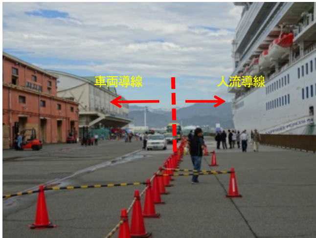
図-10 仮設物設置状
