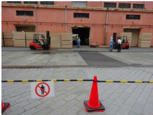
図-11 仮設物設置状況
