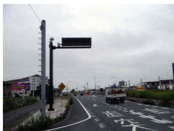
図-9 新設道路情報板の設置状況
