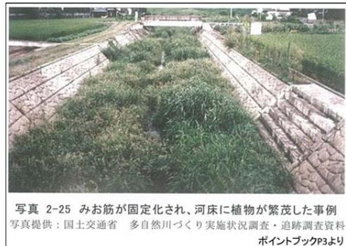
写真-10 滞筋が固定化された事例
