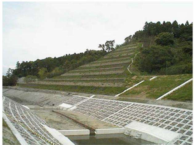
写真-6 施工直後の掘削法面
