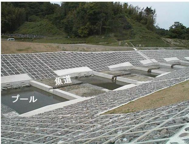
写真-5 施工直後の連続落差工
