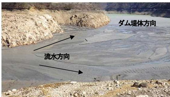
写真-5 貯水池堆積物浸食状況（平成28年3月）
