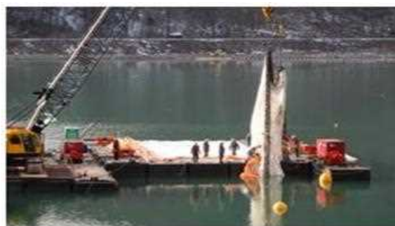
写真-3 沈下式汚濁防止フェンス
