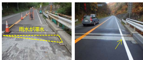
写真-13 排水柵直近の構造改善事例
