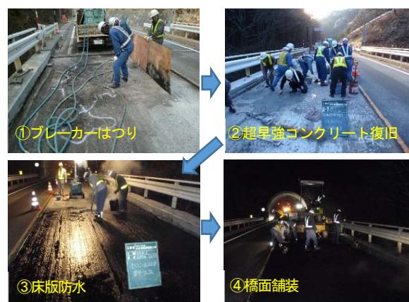
写真-5 前回即日復旧の補修状況
