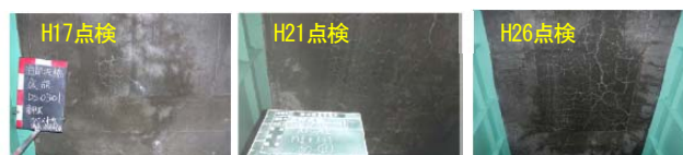
写真-2 橋梁点検による経年変化
