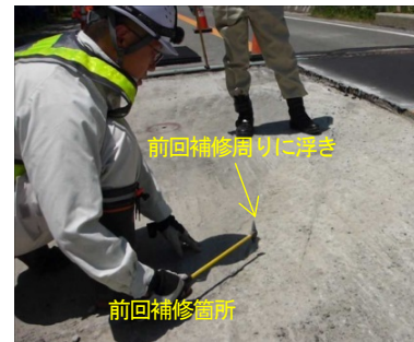
写真-8 ブレーカーはつり周辺箇所の劣化
