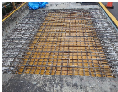
写真-7 フランジ上を残した床版打換
