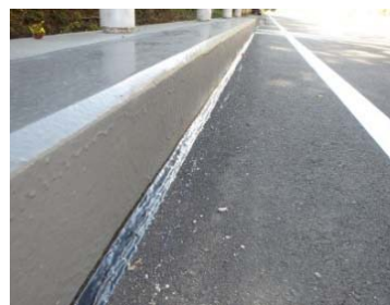
写真-11 高性能防水設置状況
