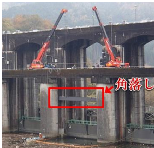
図-4-6 角落し設置状況
