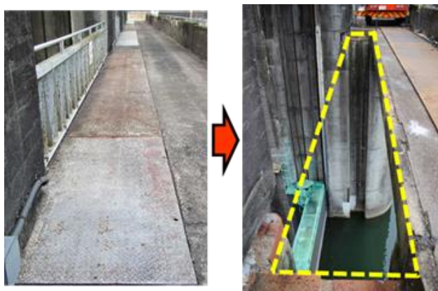
図-4-4 管理橋・手摺の取り外し（黄枠が角落し設置箇所）
