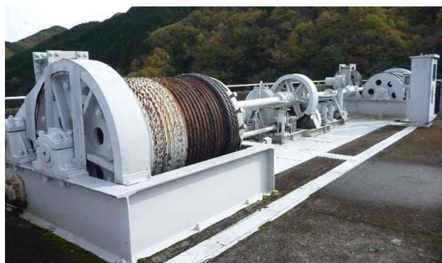
図-1-5 開閉装置（ワイヤーロープウィンチ式）
