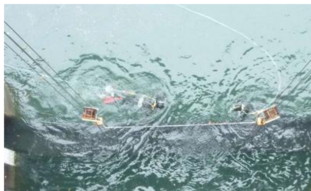
図-4-7 潜水土による水密作業状況
