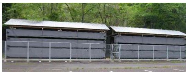
図-4-1 丸山ダムの角落としゲート（格納状況）
