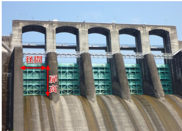
図-1-4 扉 体（鋼製ローラゲート）
