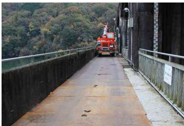
図-4-3 敷鉄板の敷設
