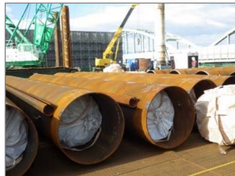
写真-10 保全対策実施状況（吸音フロート）
