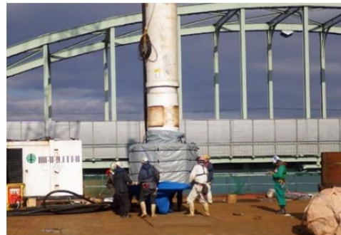
写真-9 保全対策実施状況（打撃部への防音カバー）
