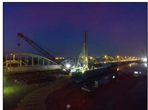
写真-14 夜間の工事状況（中堤）
