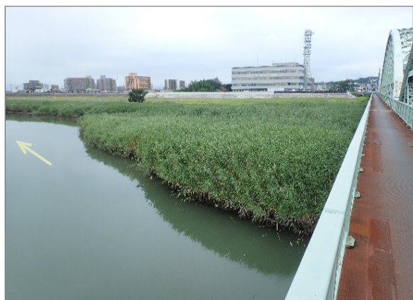
写真-4 施工前のヨシ原の状況(現橋下流側)
