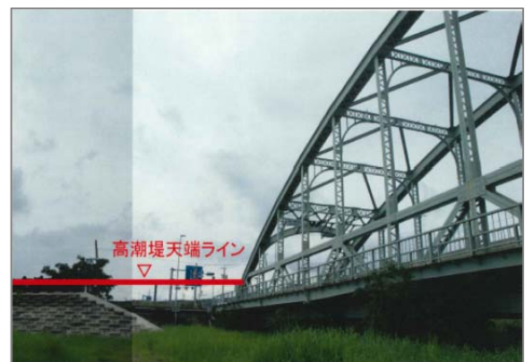
写真-3 暫定河川堤防
