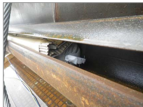
写真-11 保全対策実施状況（パイルセイバー）
