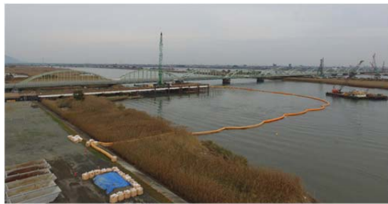
写真-15 汚濁防止膜の設置状況（揖斐川右岸）
