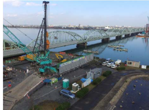
写真-12 昼間の工事状況（中堤）
