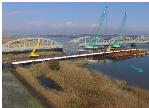
写真-6 仮栈橋からの施工状況
