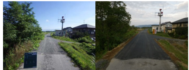
写真-3 舗装前（左）と舗装後（右）
