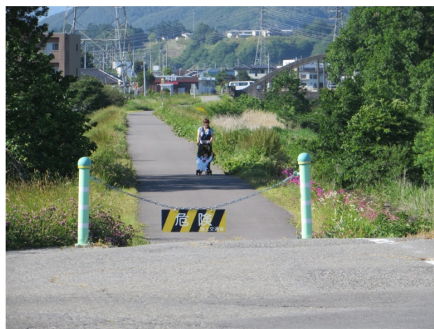
写真-11 安全になった管理用通路
