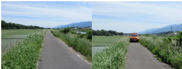
写真-5 すれ違い困難な管理用通路
