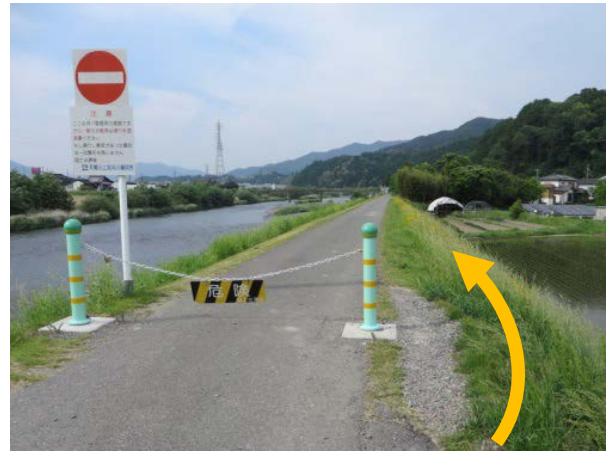
写真-8 堤内側を拡幅
