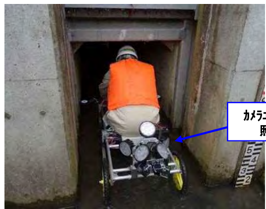
樋門点検機械 後部
