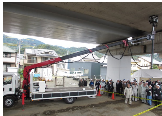
④損傷検知装置
