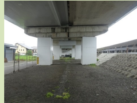
写真は蒲原高架橋
