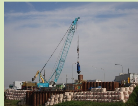
写真は南陽橋橋台工事
