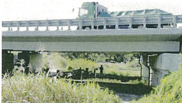
対象とした橋梁床版
