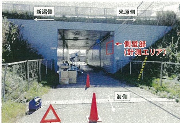
ボックスカルバートにおける探査状況
