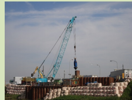
写真は南陽橋橋台工事
