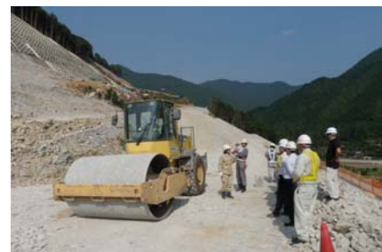
写真-18 建設ICT現場見学会(振動ローラ)
