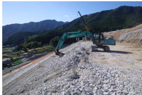
写真-14 丁張りに合わせた法面整形
