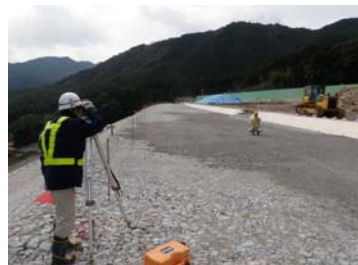
写真-10 TS出来形測定(路体盛土工)
