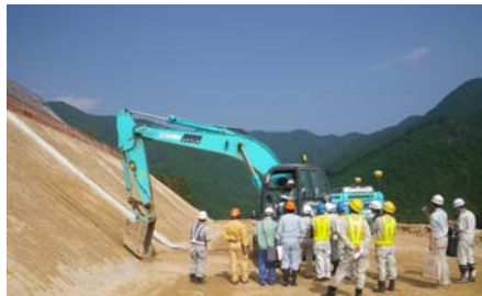
写真-16 建設ICT現場見学会(バックホウ)
