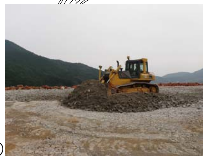
写真-1 敷均し状況
