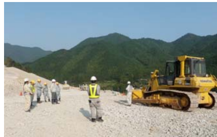
写真-17 建設ICT現場見学会(ブルドーザ)
