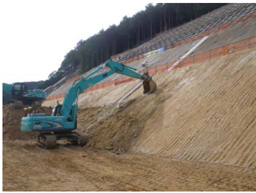
写真-7 法面整形状況(バックホウマシンガイダンスシステム)
