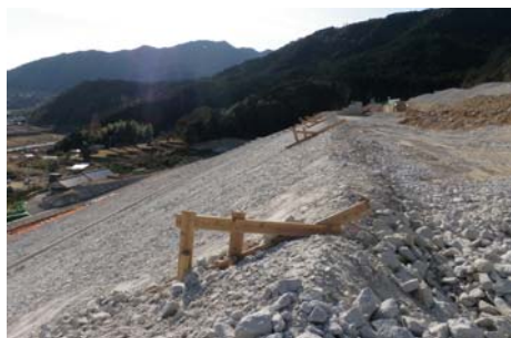
写真-13 丁張りの設置
