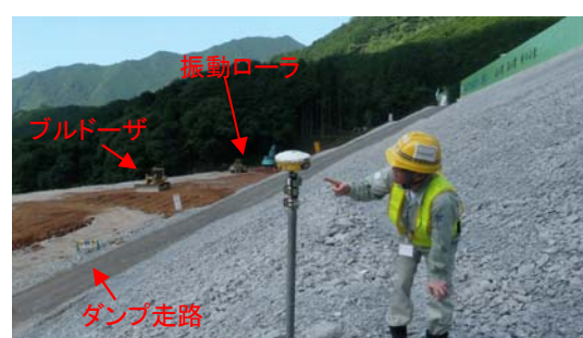
写真-6 GNSS設置状況
