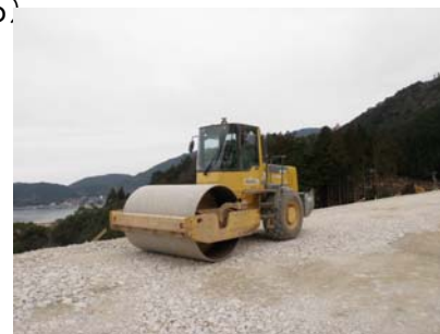
写真-3 転圧状況
