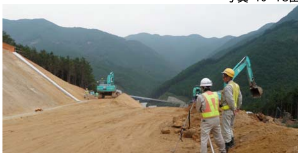
写真-12 TS出来形測定(掘削工)
